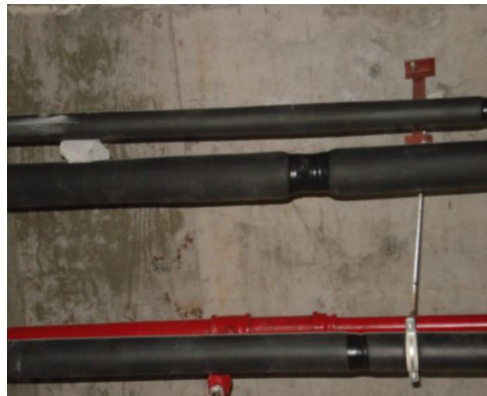
Стыки имеют тонкую теплоизоляцию
