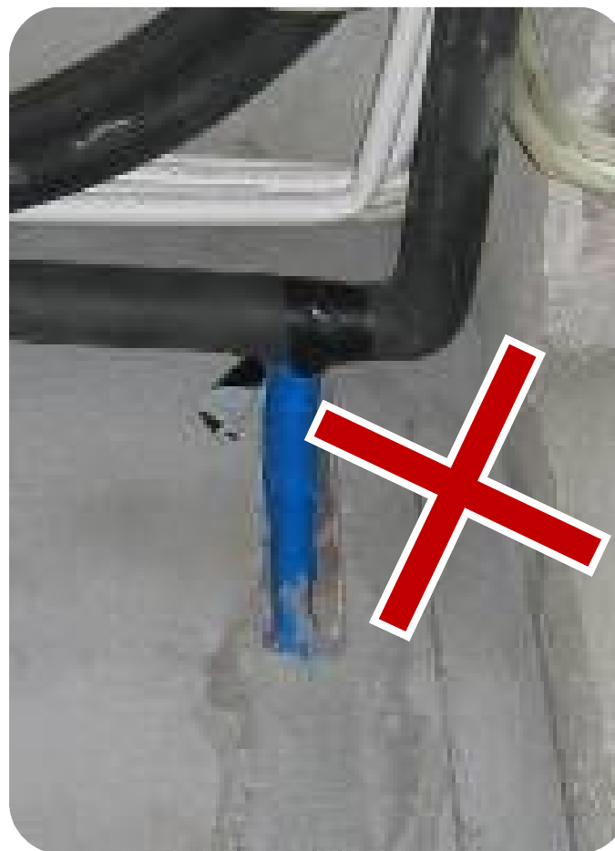
Нет теплоизоляции
