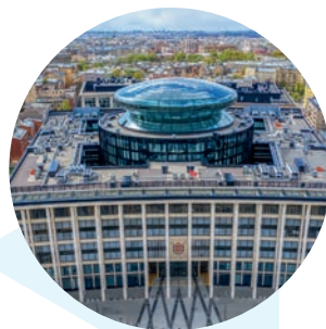
БЦ «Невская ратуша», г. Санкт Петербург
