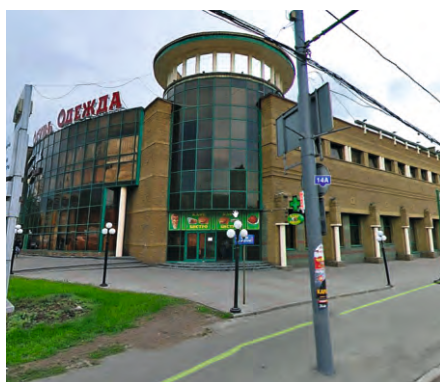
Торгово-развлекательный центр г. Москва Мультизональные системы Dantex
