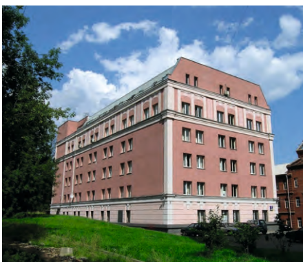
Офисный центр г. Москва Мультизональные системы Dantex
