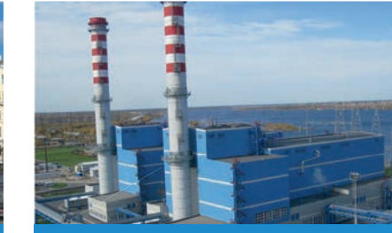
Нижневартовская ГРЭС, г. Нижневартовск, мультизональные системы MVS DANTEX
