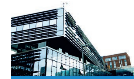
Частная школа «Новый взгляд», г. Москва, мультизональные системы VRF DANTEX
