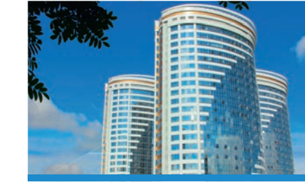
ЖК «Флотилия», г. Москва, мультизональные системы MVS DANTEX
