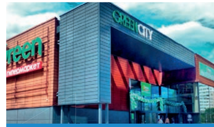
ТРЦ Green City, г. Минск, мультизональные системы MVS DANTEX
