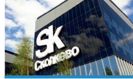
Инновационный центр «Сколково», г. Москва, фанкойлы, мультизональные системы MVS DANTEX
