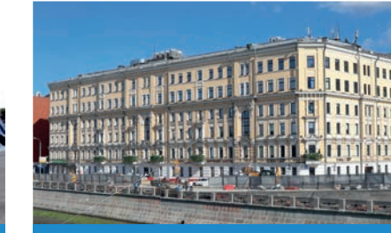
БЦ «Кадашевский», г. Москва, мультизональные системы VRF DANTEX
