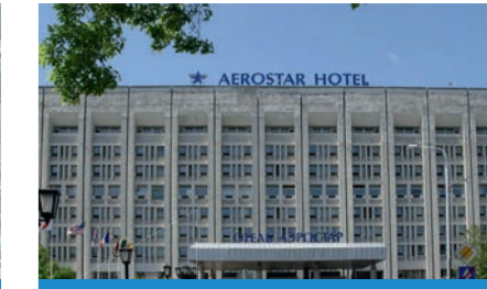
Гостиница «АЭРОСТАР», г. Москва, мультизональные системы VRF DANTEX
