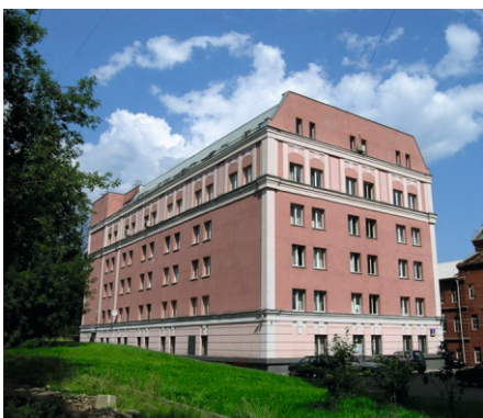
Офисный центр г. Москва Мультизональные системы Dantex
