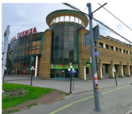
Торгово-развлекательный центр г. Москва Мультизональные системы Dantex
