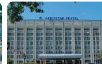
Гостиница «АЭРОСТАР», г. Москва, мультизональные системы VRF DANTEX
