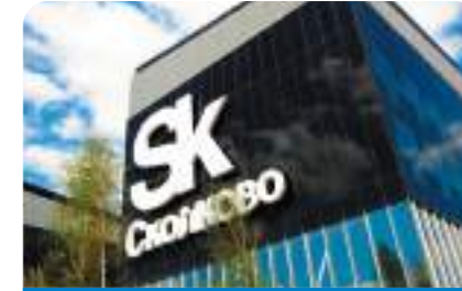
Инновационный центр «Сколково», г. Москва, фанкойлы, мультизональные системы MVS DANTEX
