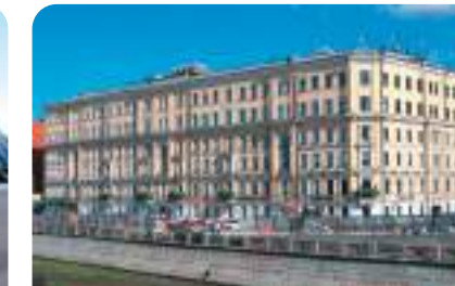
БЦ «Кадашевский», г. Москва, мультизональные системы VRF DANTEX
