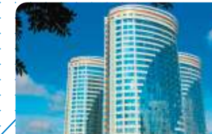
ЖК «Флотилия», г. Москва, мультизональные системы MVS DANTEX
