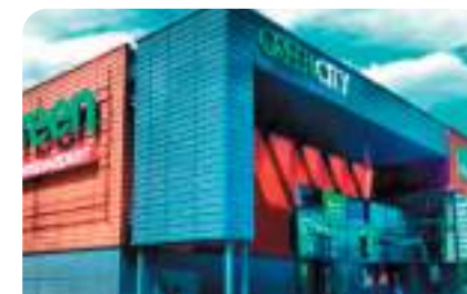
ТЦ Green City, г. Минск, мультизональные системы MVS DANTEX
