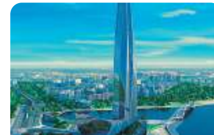
«Лахта центр», г. Санкт-Петербург, фанкойлы, прецизионные кондиционеры DANTEX
