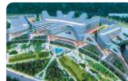
Центр радиационных технологий «Рад», г. Всеволожск, чиллеры DANTEX с системой FREECOOLING
