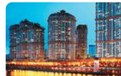
ТРЦ ЖК «Алые Паруса», г. Москва, мультизональные системы MVS DANTEX
