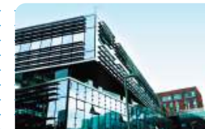
Частная школа «Новый взгляд», г. Москва, мультизональные системы VRF DANTEX
